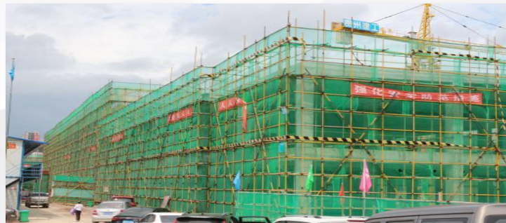
正在建设中的凯里综合客运枢纽（二期）
