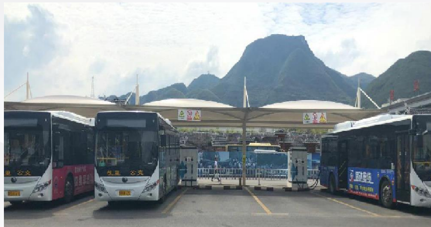
凯里综合客运枢纽项目（一期）公交换乘站充电站
