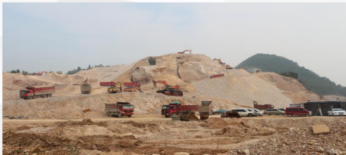
正在建设中的凯里市城东绿色公共交通综合体
